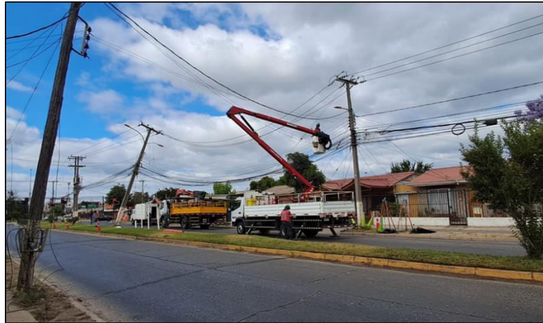
Imagen N°100: Equipo de Servicios Operativos en reparaciones de tendido eléctrico, diciembre 2024. Fuente: Oficina de Gestión de Riesgos de Desastres, Municipalidad de Quillota.
