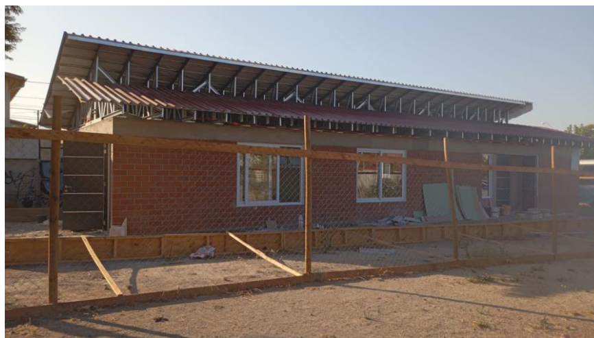
Imagen N°85: Avance Obras de Proyecto Construcción Sede Vecinal Los Canelos, diciembre 2024. Fuente: Secretaría Comunal de Planificación, Municipalidad de Quillota.
