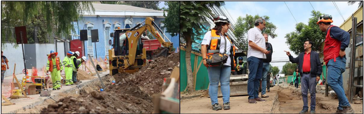
Imagen N°19: Visita a terreno y fiscalización de obras de Esval Primera Etapa en Calle Merced, febrero 2024.
