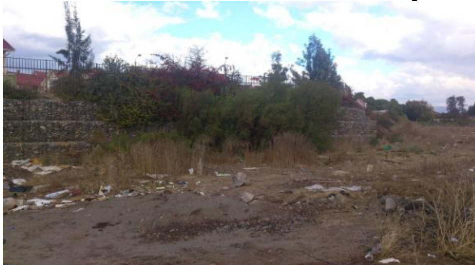
Ilustración 48 Muro de Gaviones Sector Norte Río Aconcagua.
