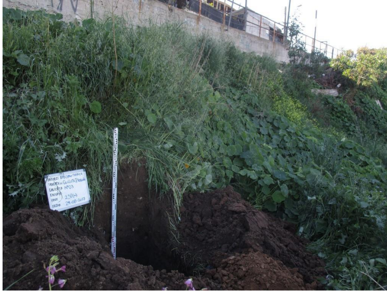
Ilustración 82 Ejecución calicata C-03.
