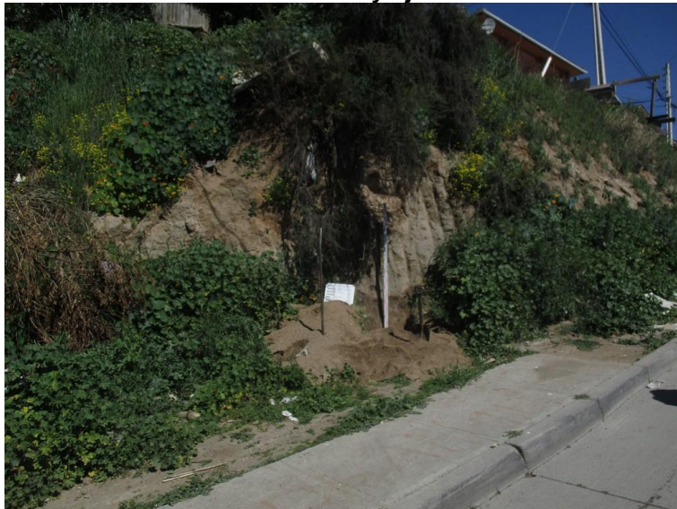
Ilustración 81 Material excedente y ejecución de calicata C-02.
