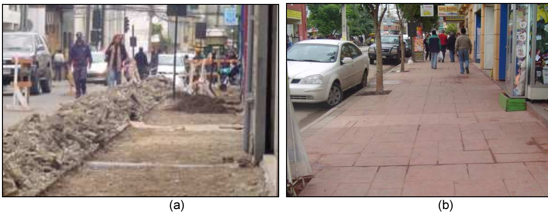
Figura 10. Trabajos de reposición de soleras (a) Antes; (b) Después.
