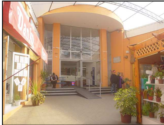
Figura 14. Centro comercial "Caracol", Calle O'Higgins
